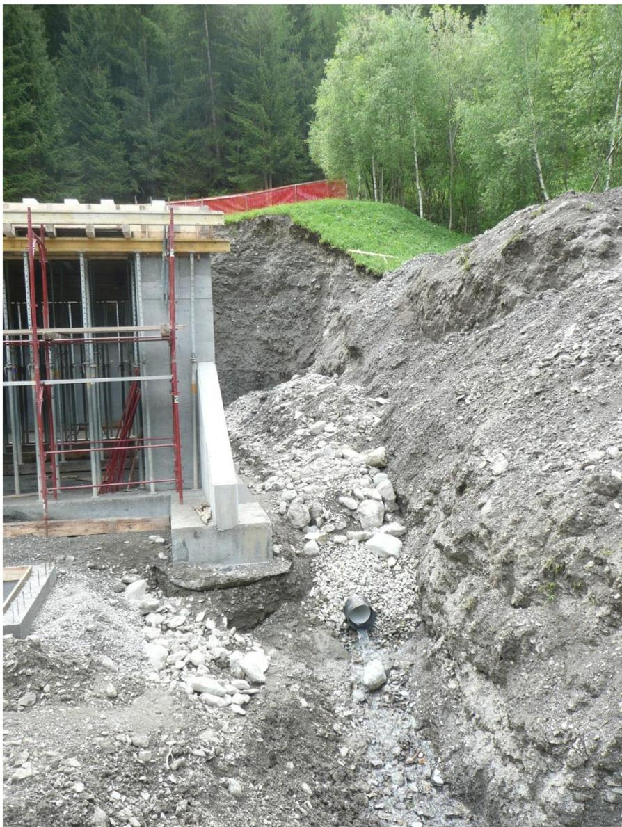
PARTICOLARE DEGLI INTERVENTI DI DRENAGGIO, PREVISTI IN VARIANTE, PER LA RACCOLTA E L'ALLONTANAMENTO DELLE CONSISTENTI VENUTE DI ACQUA INTERCETTATE DURANTE GLI SCAVI
